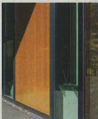
Les vitrages orangés installés au CPF.
